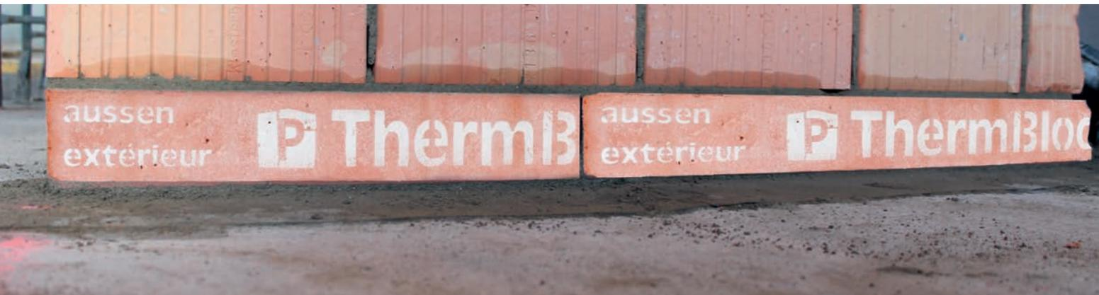
Die ThermBloc-Dämmelemente bestehen aus hochfestem Beton und expandiertem Polystyrol-Hartschaum mit Graphit-Zusatz. Produkteigenschaften: Wärmedämmung und Kapillarwassersperre in einer Funktionsschicht zur Vermeidung von Wärmebrücken und aufsteigender Feuchtigkeit.
