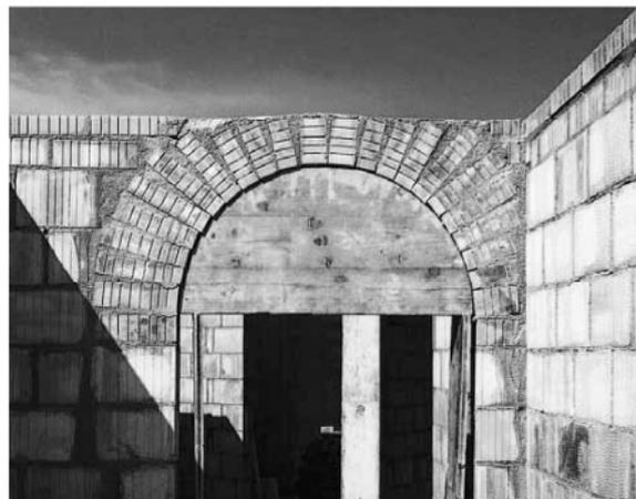
Dank dem Einsatz von SUMO Backsteinen konnte bei diesem Rundbogen eine Mischbauweise vermieden werden. Der Verband mit SwissModul Backsteinen ist deutlich sichtbar.
