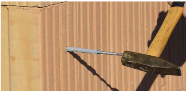
Dübel mit Hammer einschlagen
