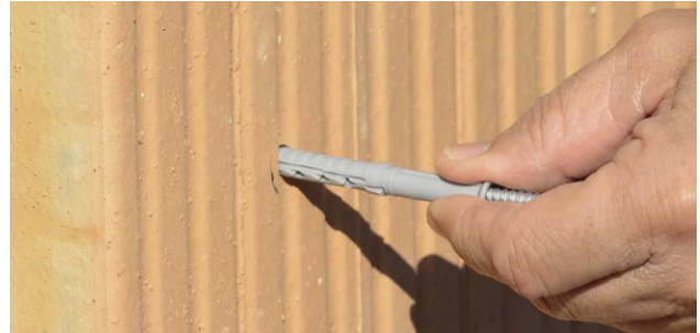
Dübel einsetzen
